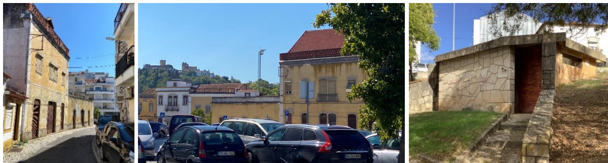
Figura 3.23 – Edifício E01 e edifício de instalações sanitárias públicas (G24)
