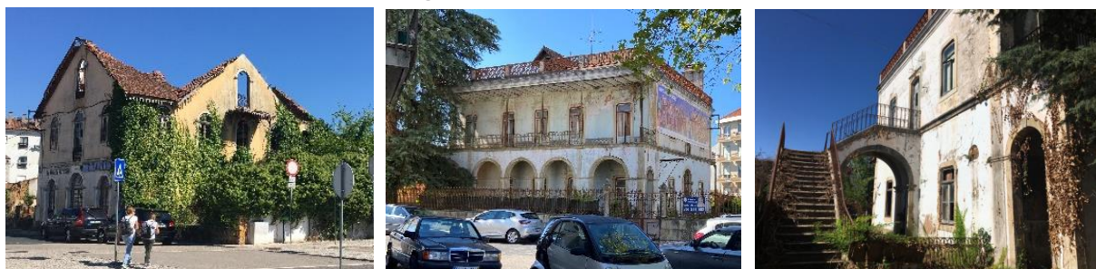
Figura 3.21 – Edifícios D19 e F05
