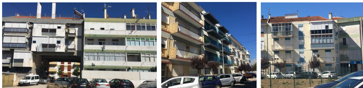
Figura 3.16 – Exemplos da descaracterização arquitetónica
