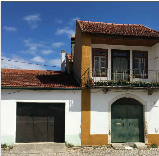
CEX6. soleiras e rampas de acesso a garagem em betão
