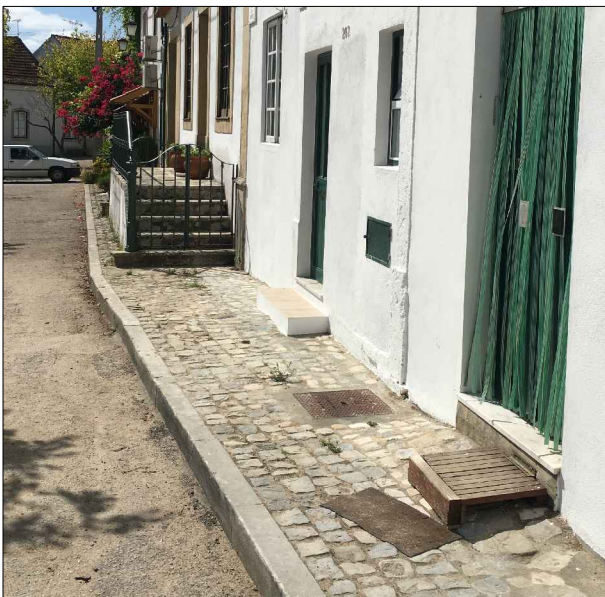
CEX1. lancil de calcário com 12cm de espessura e CEX5. patim em betão capeado a pedra calcária/tijoleira na soleira
