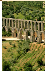
Aqueduto dos Pegões Altos Pegões Altos Aqueduct
