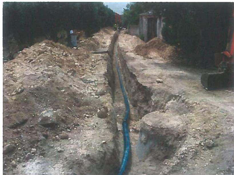
Foto 12 – substituição de conduta de distribuição de água – Peralva
