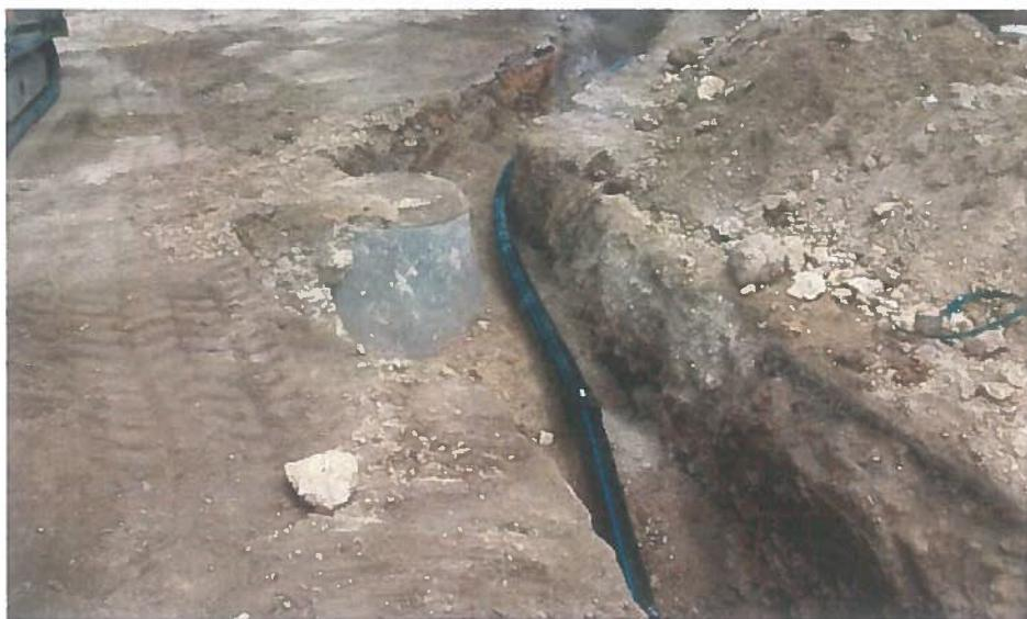
Foto 11 – substituição de conduta de distribuição de água – Peralva
