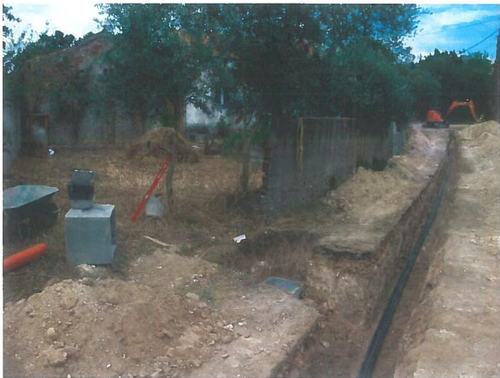
Foto 10 – substituição de conduta de distribuição de água – Peralva
