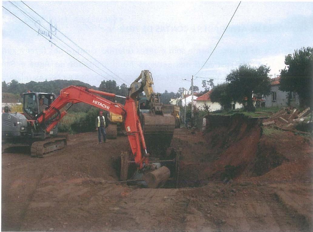
Obras: Rede de saneamento de águas residuais, Ponte da Vala
