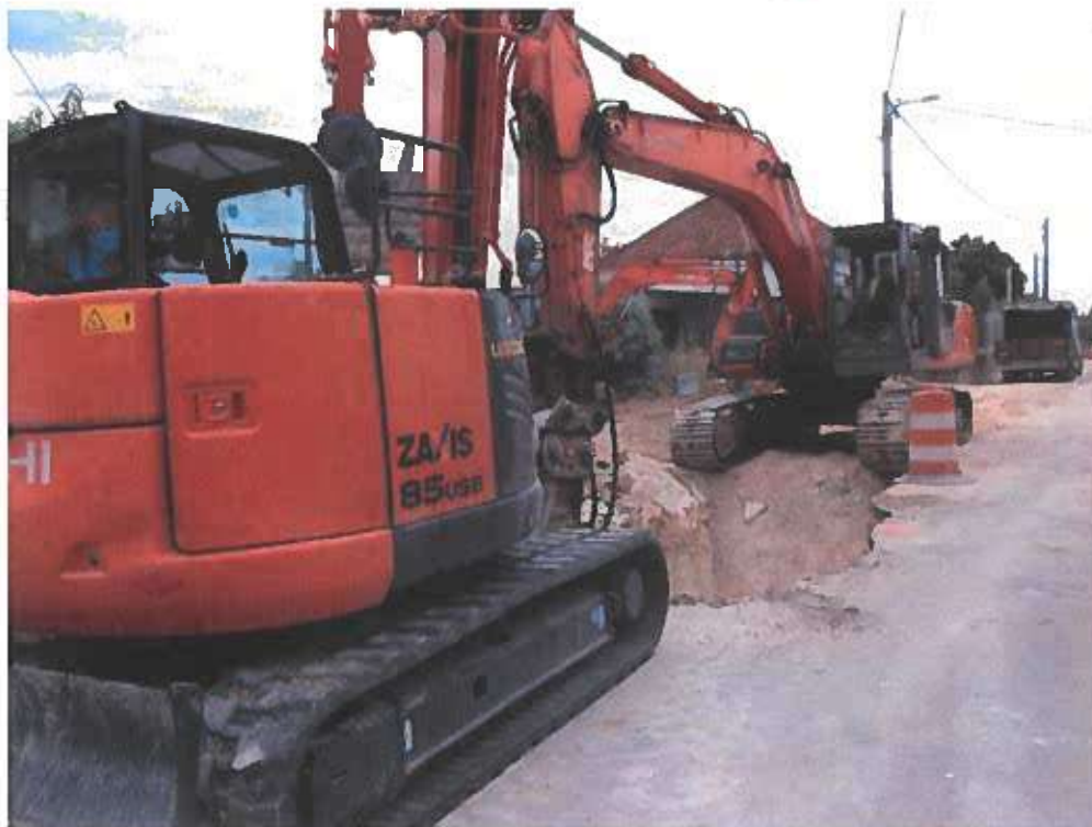
Foto 9 – Obra de saneamento de águas residuais domésticas – Peralva (2019)
