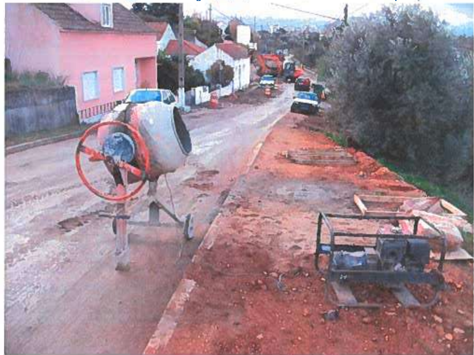
Foto 8 – Obra de saneamento de águas residuais domésticas – Ponte da Vaia (2019)
