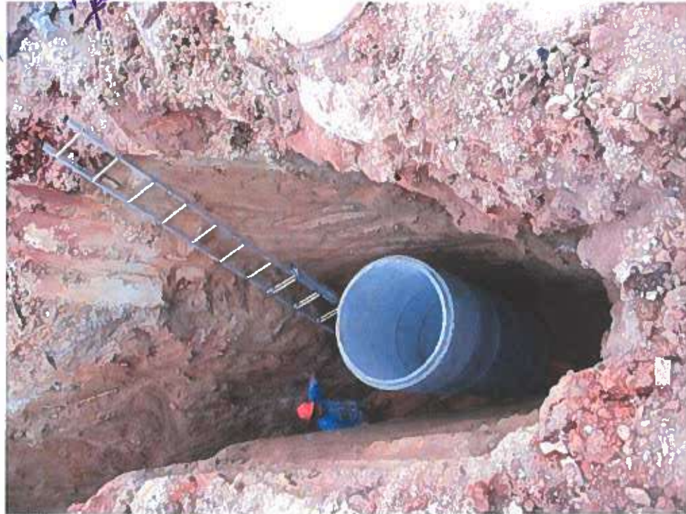
Foto 7 – Obra de saneamento de águas residuais domésticas – Charneca da Peralva (2019)
