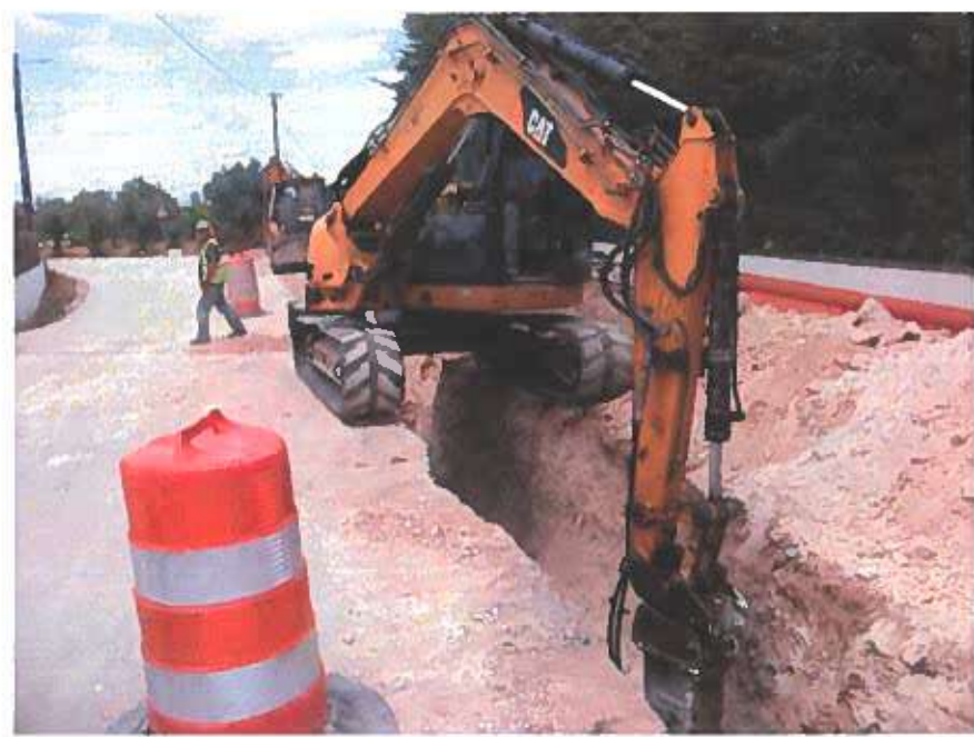
Foto 3 – Obra de saneamento de águas residuais domésticas – Peraiva (2019)
