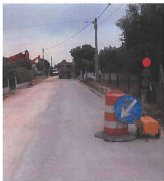
Foto 1 – Obra de saneamento de águas residuais domésticas – Peralva (2019)
